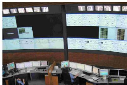
Im 6. Segment sind die Energieversorgungs-Arbeitsplätze eingerichtet (siehe großes Bild oben), welche der Energie- und Netzwerktechnik (Energie/Traktionsstrom, Rolltreppen etc.) für die U-Bahn und – neu – auch für die Straßenbahn dienen. Ferner gibt es abgesetzte Arbeitsplätze der Aufsicht.
